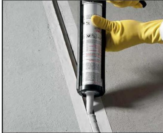
Figura 2 - Colagem para vedação de juntas de dilatação verticais e horizontais.
