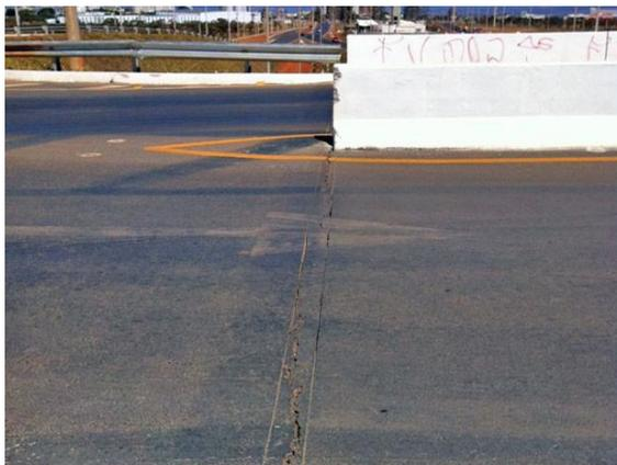
FIGURA 38: Fissuras nas juntas de dilatação de uma ponte.
