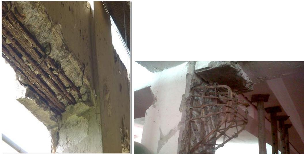
FIGURA 37: Corrosão devido a entrada de água pelas aberturas das juntas.
