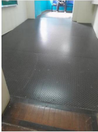
Figura 64 - Rampa sem piso tátil
