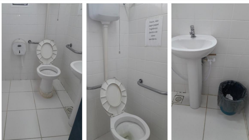
Figura 54 – Banheiro Angra dos Reis
