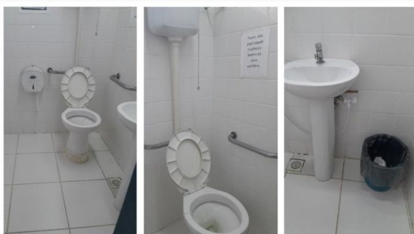
Figura 28 - Banheiro Angra dos Reis
