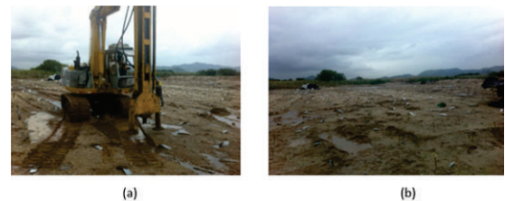
Figura 6: (a) Cravação de drenos fibroquímicos; (b) Localização de drenos e marcação de drenos fibroquímicos executados
