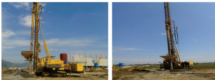
Figura 7: Execução das colunas de brita no Centro Metropolitano: (a) vista lateral; (b) vista frontal
